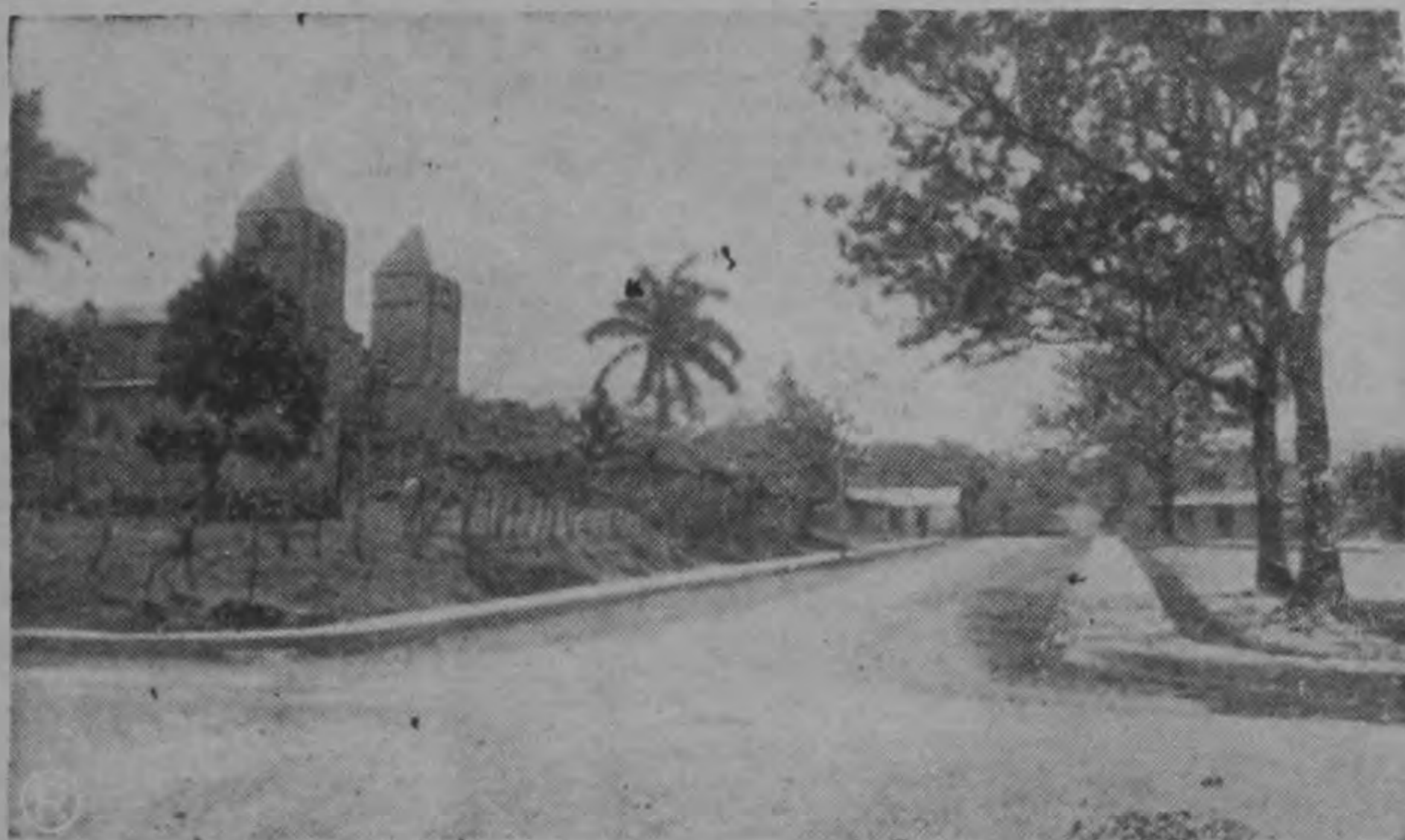
Se aprecia en la gráfica, el aspecto limpio y bello que tomó el centro de Villa Colón, gracias a la labor de urbanismo del INVU en esa importante localidad. El Instituto construyó 900 metros de acera, cordón y cuneta con sus respectivos tragantes para aguas y pluviales. Una acera principal rodea a toda la plaza, y la otra la manzana de la iglesia. El INVU colaboró con la Municipalidad del lugar haciendo el trazado de estos trabajos, cediendo personal y dando la asesoría técnica necesaria para una buena ejecución de la obra. La Municipalidad colaboró con el costo. También esa Corporación le donó al Instituto unos céntricos terrenos donde el INVU está construyendo 7 viviendas para familias de pocos recursos: 4 son de 3 dormitorios y 3 de 2.
